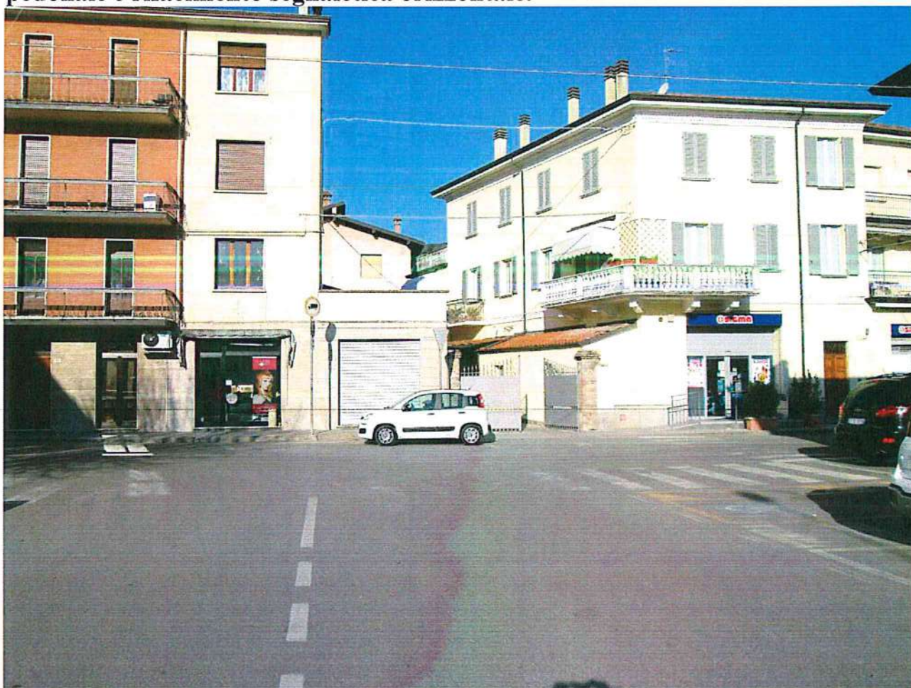
FOTO N.13- Via 24 Maggio integrare segnaletica verticale di attraversamento pedonale e rifacimento segnaletica orizzontale.
