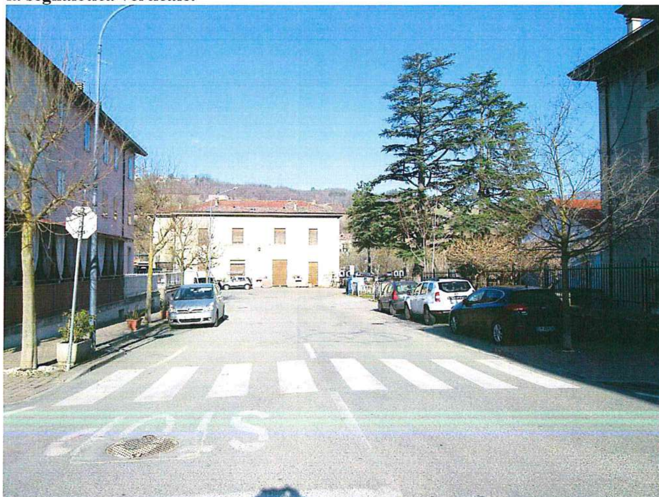
FOTO N.18 Via Donatori del Sangue, integrare l'attraversamento pedonale con la segnaletica verticale.
