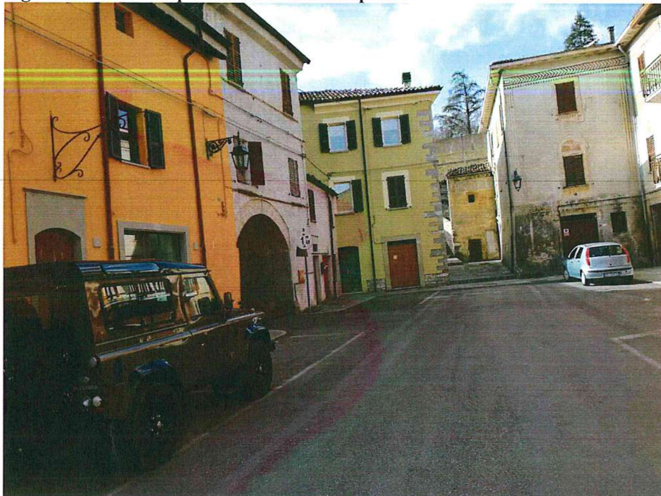
FOTO N. 12- Piazza S. Ambrogio all'ingresso di via Voltone, sostituire il segnale di divieto in quanto scolorito e non più visibile.
