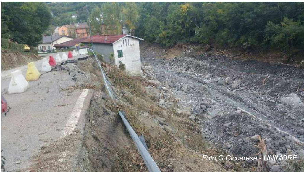
Figura 11: Rio Grondana immediatamente a monte dell'abitato di Ferriere. In primo piano la strada Provinciale del Passo del Mercatello danneggiata dalla piena.
