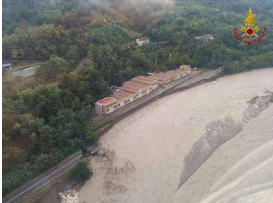
Figura 12: Foto aerea del tratto viario della SP 654 distrutta dalla piena a Bettola.
