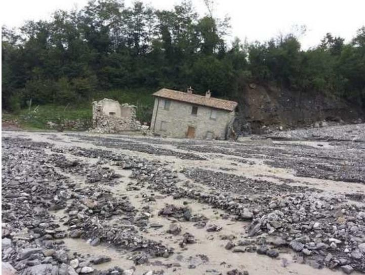
Figura 10: Molino di Pomarolo, irrimediabilmente danneggiato, a monte dell'abitato di Ferriere alla confluenza tra il Torrente Grondana e il Rio Ricco ([www.altavaltrebbia.net](http://www.altavaltrebbia.net)).
